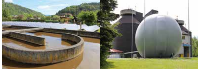
Photovoltaik-Anlage und Biogasspeicher an der Abwasserreinigungsanlage Kapfenberg Foto: Wasserverband Mürzverband
