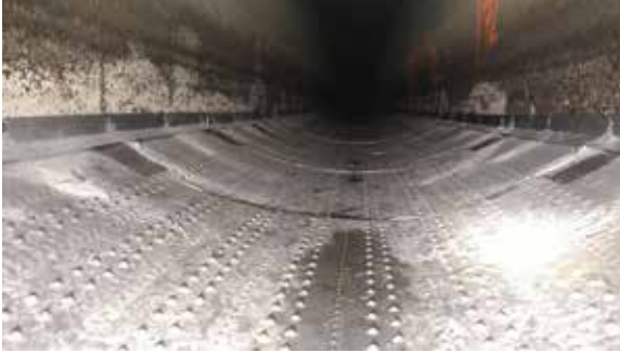
Verlegte Wärmetauscherelemente im Abwasserkanal Foto: Rabmer Greentech GmbH
