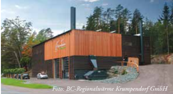
Foto: BC-Regionalwärme Krumpendorf GmbH
