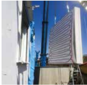
Fassadenmodul zum Testen mit Bauteilaktivierung
