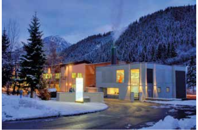
Biomasseheizwerk Wald im Pinzgau
