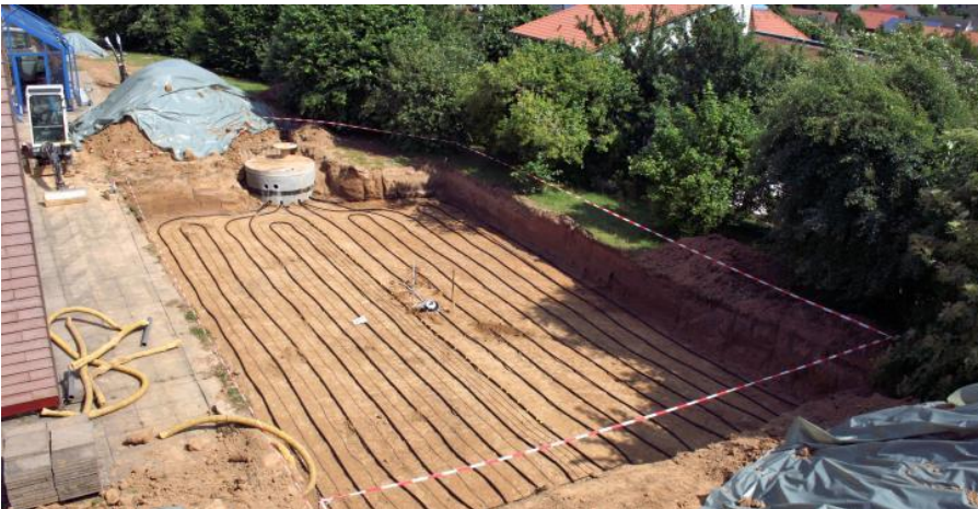
Flächenkollektor Quelle: Projekt Geosol
