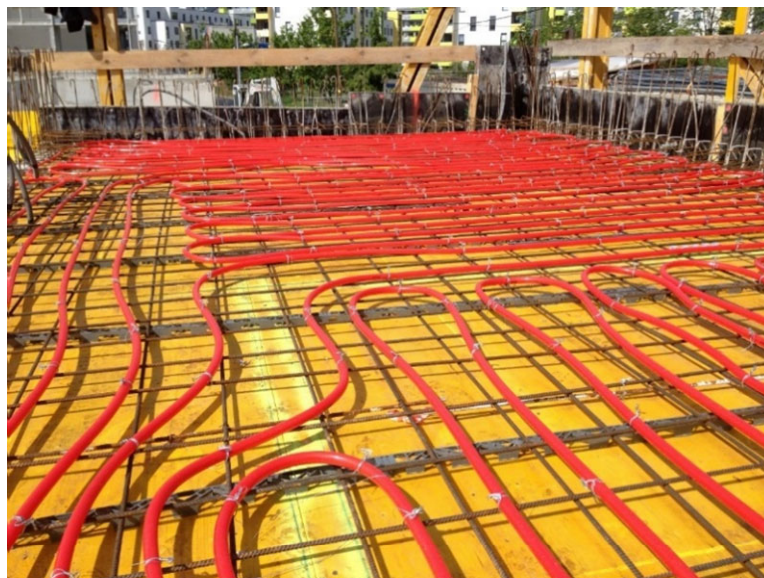
Abbildung 12: Verlegte Heizkreise in der Decke, Projekt Mühlgrund in Wien (©FIN – Future IS Now, Kuster Energielösungen GmbH)
