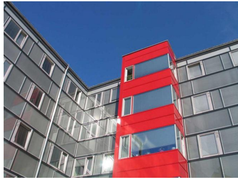
Wohnanlage Markartstraße Linz – Sanierung in Passivhausqualität. Quelle: ARCH MORE ZT GmbH
