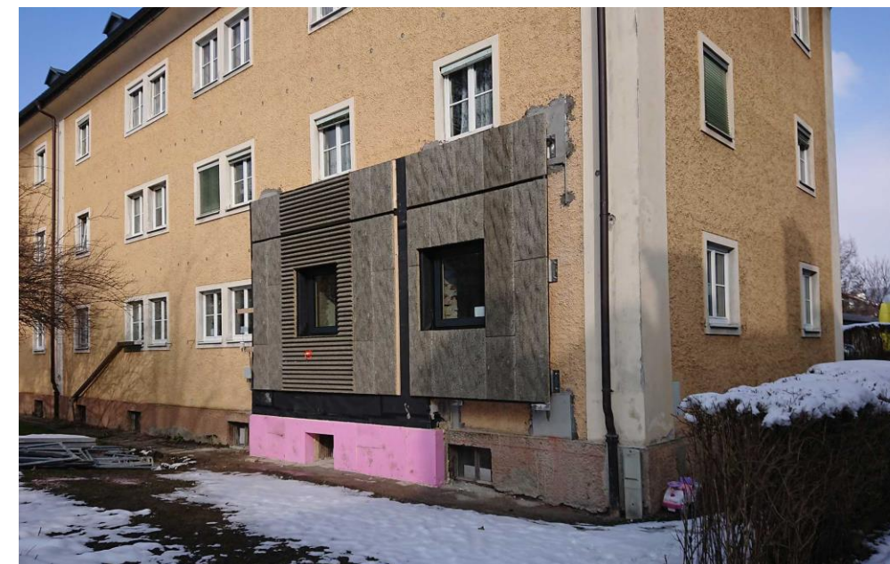
Projekt Wohnen findet Stadt! Teils vorgefertigte Multifunktionsfassade. Quelle: Fh Salzburg; Schweizer et. al
