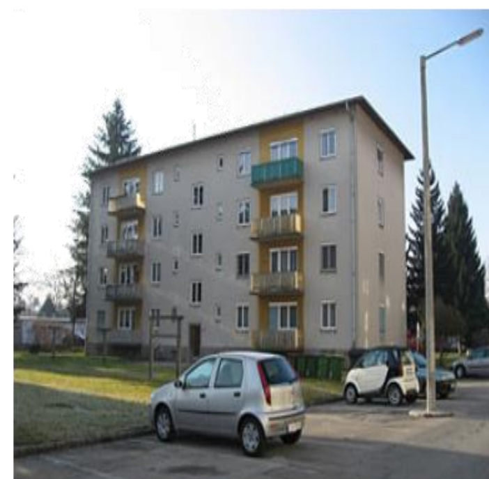
DIESELWEG GRAZ. Quelle: GIWOG; GAP solution; AEE INTEC
