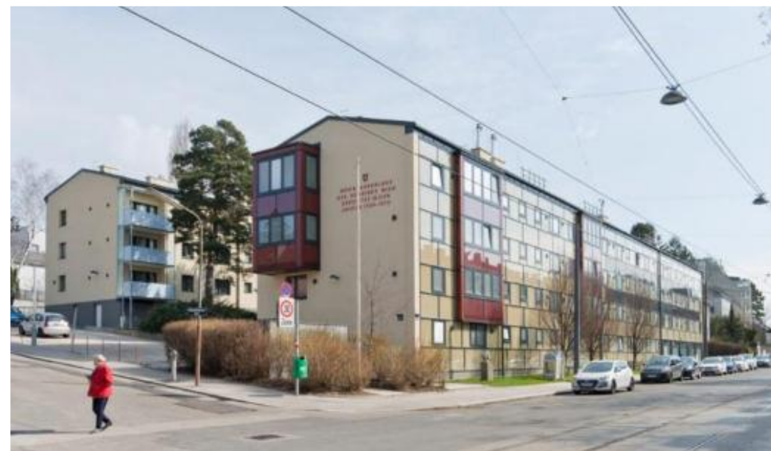
PASSIVHAUS-SANIERUNG EINES WIENER GEMEINDEBAUS. Quelle: Treberspurg & Partner Architekten
