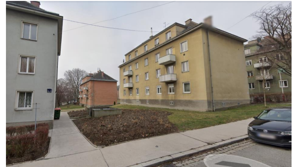
Beispiel: 1180 Wien - Wielemansgasse 13-23 – 13 Wohnblöcke – 162 WE
