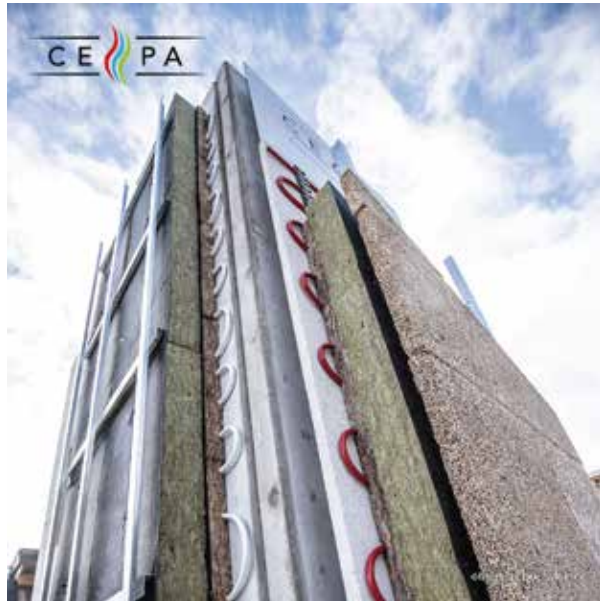
Die Fassade als Energiespeicher – patentierte Energiefassade CEPA
