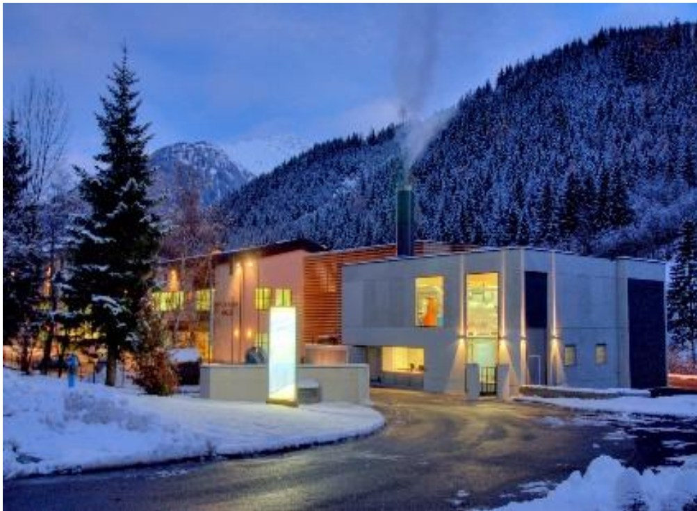
Figure 5: DH plant in Wald im Pinzgau. Source: Salzburg AG
